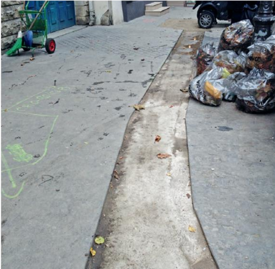
Mise à nue de la couche de béton sous l'asphalte du trottoir après réfection d'une canalisation
